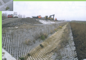
R 55 – Stavba 03 Skalka - Hulín
